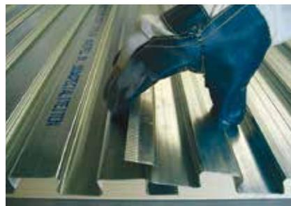
Une rangée de profils LEWIS® peut être glissée aisément au-dessus ou en dessous des ondes de la rangée précédente.
