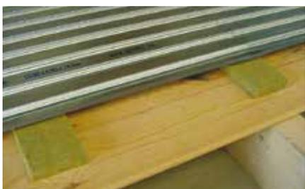
Sur les planchers, les bandes doivent être appliquées au droit des solives (écartement maximal de 500 mm). Le recouvrement transversal du profilé LEWIS® ( $\geq 100$  mm) doit toujours être réalisé au droit d'une bande résiliente. Isoler le plancher des relevés à l'aide de bandes périphériques en laine de roche LEWIS® ou produit résilient équivalent. Eviter les ponts thermiques au droit des tubes de chauffage central et des canalisations en les isolant avec le même produit.
