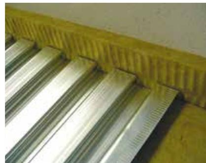
Le plancher LEWIS® doit être isolé des relevés (murs, traversées et autres) par des bandes périphériques d'env. 10 mm.
