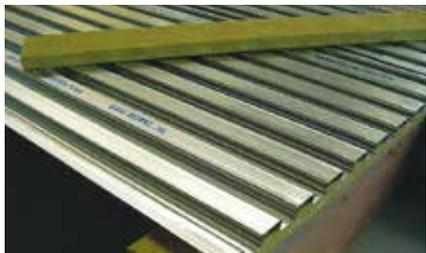
Poser des bandes de laine de roche LEWIS® d'une épaisseur de 25 mm et d'une largeur de 100 mm (ou largeur de la solive + 10 mm) ou produit résilient équivalent, directement sur les solives.
