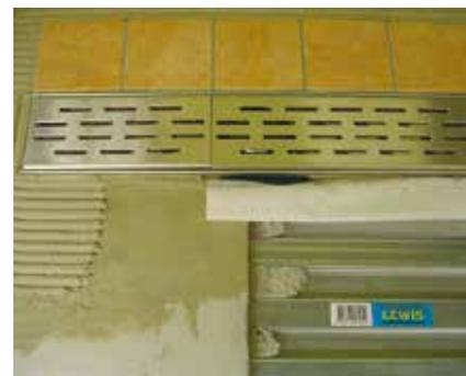
Supprimer de préférence le plancher bois existant ou assurer une ventilation en perçant des trous. Prévoir au droit de la jonction plancher-cloison un raccord d'étanchéité directement appliqué sur le béton.
