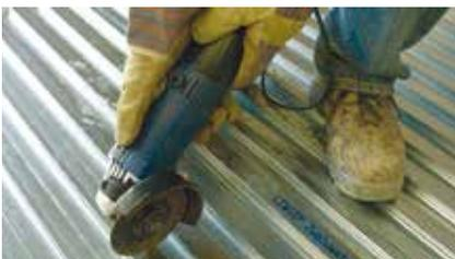
Les profils LEWIS® peuvent être découpés facilement sur mesure tant en largeur qu'en longueur, à l'aide d'une disqueuse équipée d'un disque métal. Les réservations peuvent être réalisées avec le même outillage ou à l'aide d'une scie à découper.
