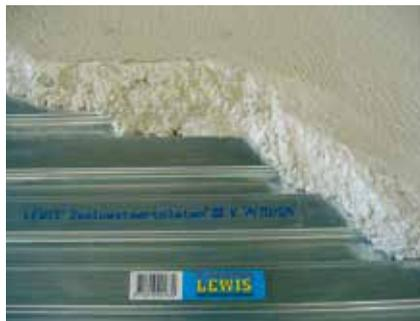
Les profilés LEWIS® servent de coffrage perdu lors de la mise en place du béton. Ils ne servent d'armature qu'après le durcissement du béton. Une finition de sol en céramique, en pierre naturelle ou de type Terrazzo (granito) nécessite une chape de béton lisse.
